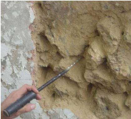
Figura 30: Exemplo da cravação da hélice de fixação com acessório para o efeito, até ela ter penetrado o comprimento de referência.
