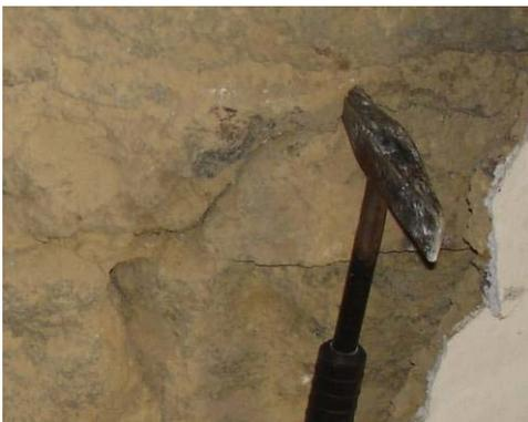
Figura 5: Exemplo de parede de alvenaria em basalto argamassada com ligante argiloso.
