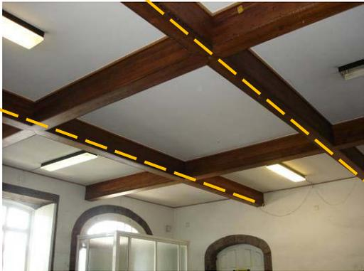
Figura 17: Grelha no tecto que oculta perfis metálicos na direcção paralela à fachada principal.
