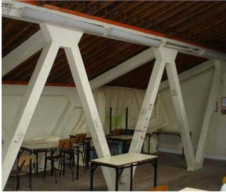
Figura 7: Exemplo de treliça em betão armado de suporte de cobertura.
