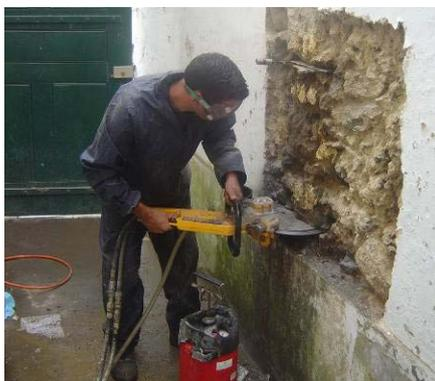
Figura 34: Abertura de rasgo em parede de alvenaria para colocação de macaco plano.
