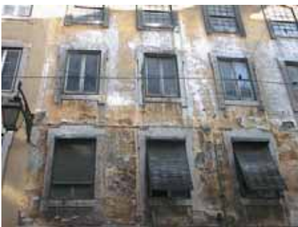
Fig. 1 - Degradação do revestimento da fachada
