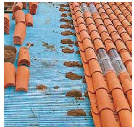
Fig. 7 - Reforço do isolamento térmico em coberturas inclinadas
