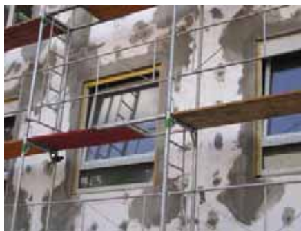
Fig. 8 – Reforço do isolamento térmico pelo exterior em fachadas
