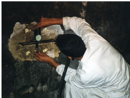
Fig. 2 – Medição das deformações da alvenaria durante a determinação do estado de tensão.
