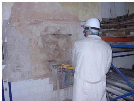
Fig. 3 – Execução do 2º entalhe para o ensaio de deformabilidade de uma parede de alvenaria.
