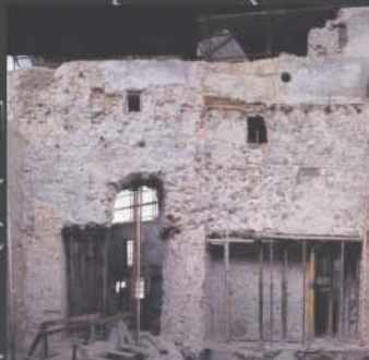
Ortofotografia do alçado de um troço de muralha islâmica, em Tavira.
