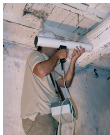
Verificação da integridade de uma viga de madeira. | 7
