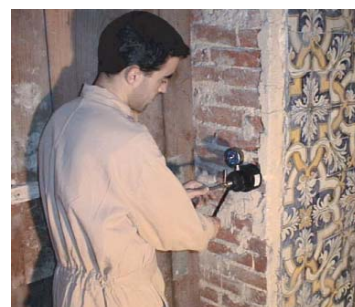
Avaliação das propriedades mecânicas de uma argamassa de assentamento, através do ensaio de arrancamento de uma hélice. | 5
