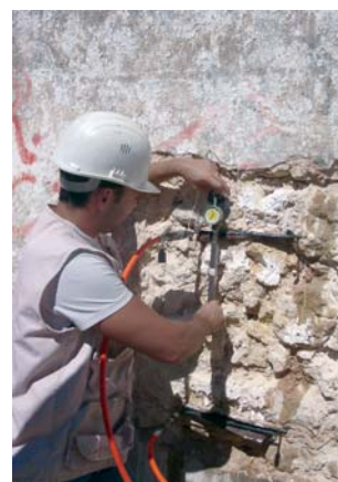
Ensaios de macacos planos: medição de deslocamentos com alongâmetro de milésimos. | 12
